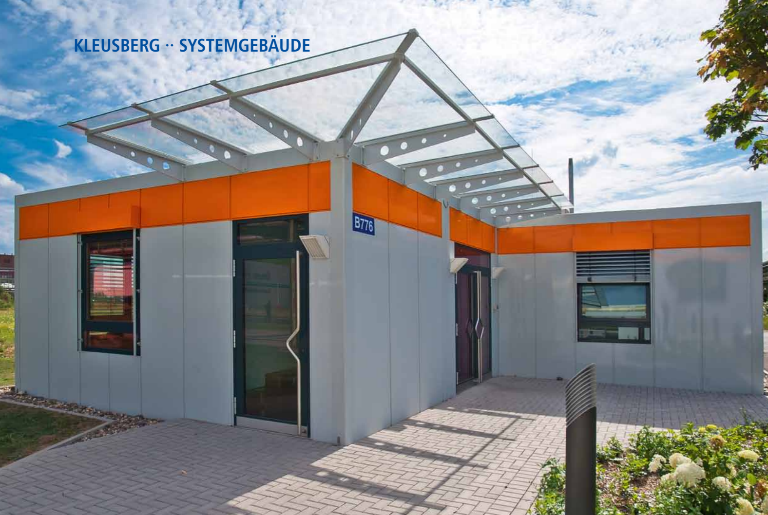
Systemgebäude bei Currenta in Dormagen – Corporate Identity durch Farbakzente
