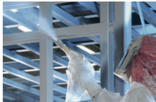
Modulfertigung im Werk Kabelsketal-Dölbau
