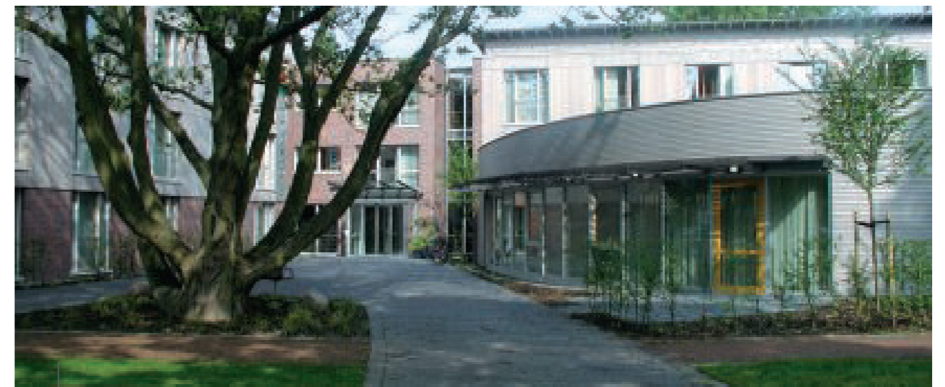
Altenpflegezentrum Neuwerk (gebaut 2003 als Passivhaus)
