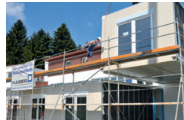
Montage eines Modulgebäudes
